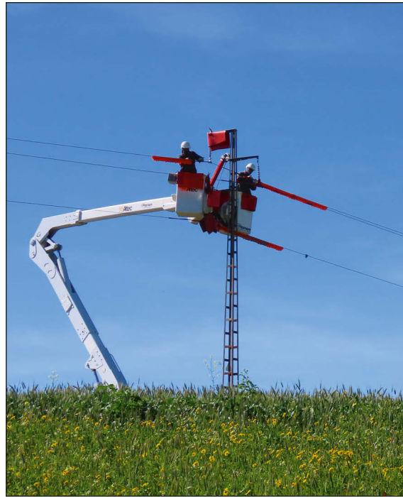
Unos operarios corrigen un apoyo eléctrico en la zona de liberación de milanos reales en el suroeste de la provincia de Badajoz.
